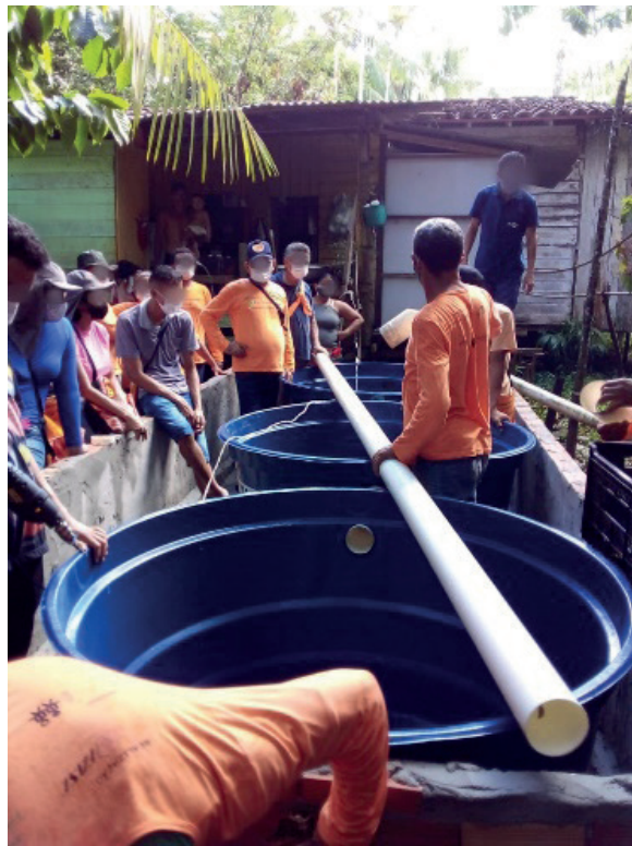
Figura 9 - Início da instalação na casa 2
