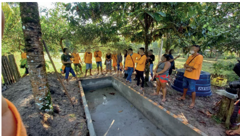
Figura 6 - Início da instalação na casa 1
